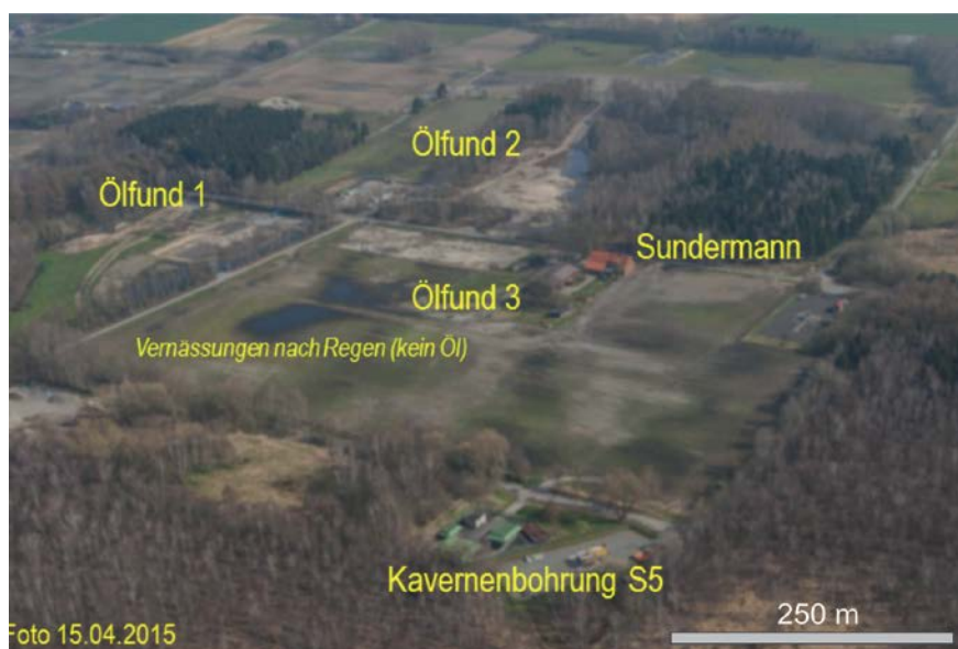
Abb. 1: Luftbild der Schadensstelle im Bereich der Kavernenbohrung S5 (Blickrichtung nach Nordost, Quelle: SGW).
